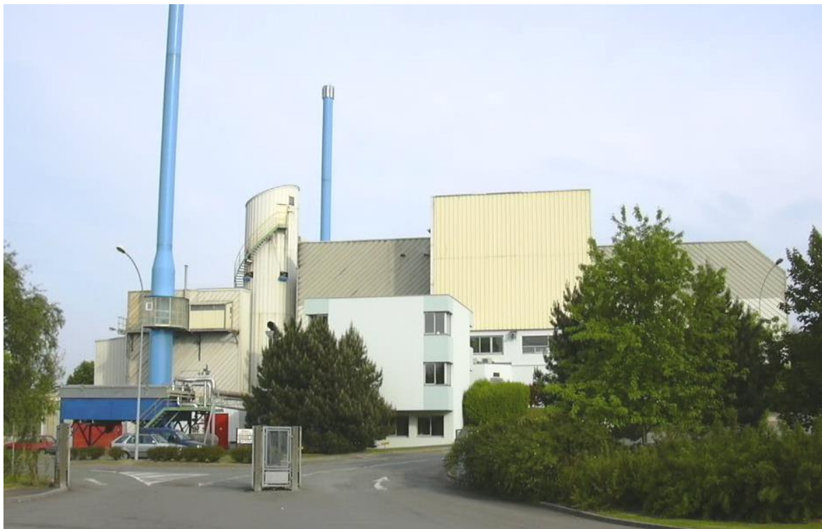
Usine d'incinération de Montbéliard
