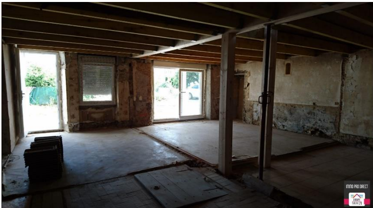
Plateau à aménager, appartement 70 m 2 à Blamont Source : IMMO PRO DIRECT, Groupe Habitat 21
